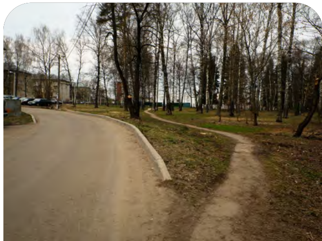
Отсутствие покрытия на пешеходных путях
