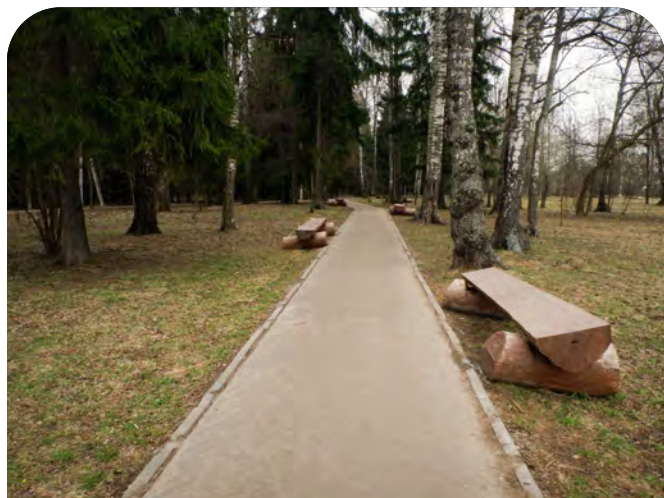
Существующие скамьи в плохом состоянии
