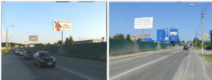
Конструкция 142 а/д. Красная Поляна-Текстильная, 0 км + 472 м, слева
