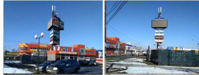
Конструкция 139 а/д. Красная Поляна-Текстильная, 0 км + 084 м, справа (Московская обл., г.о. Лобня, Краснополянский проезд, д.2)
