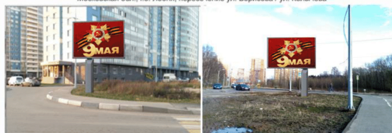
Конструкция 330 Московская обл., г.о. Лобня, пересечение ул. Борисова / ул. Кольчева
