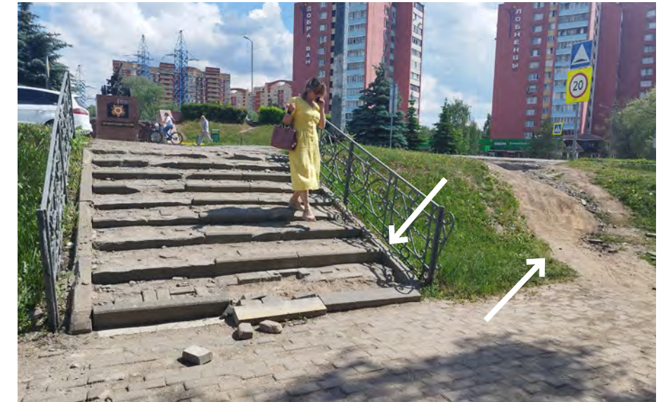
2. Лестница на главном входе
