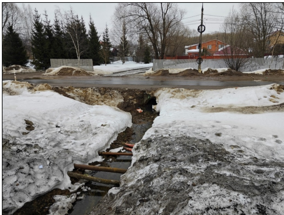
Рисунок 5 – ручей без названия выше створа перехода – железобетонная труба в теле автодорожной насыпи улицы Железнодорожной
