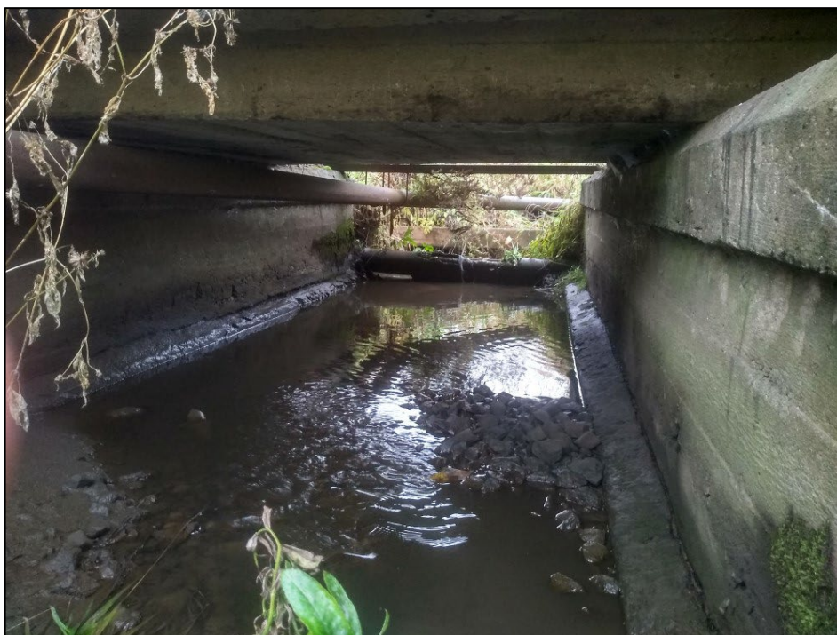
Рисунок 6.3 – Мостовой переход через р. Лобня, вид вниз по течению
