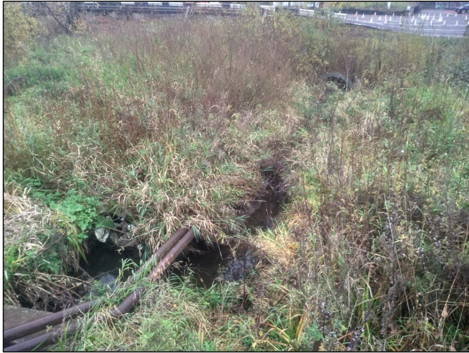
Рисунок 6.5 – Коллектор р. Лобня на входе (с южной стороны от ветки ж/д)
