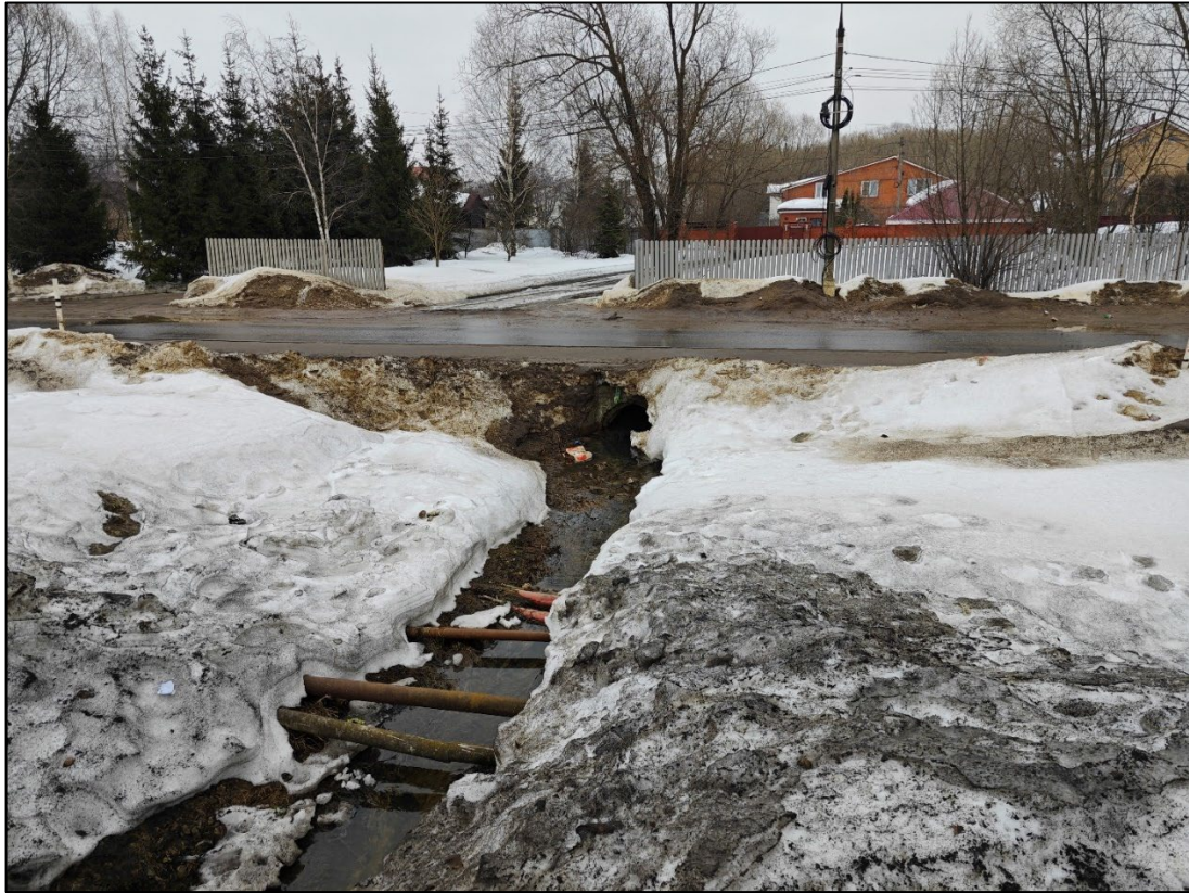
Рисунок 6.7 – ручей без названия выше створа перехода – железобетонная труба в теле автодорожной насыпи улицы Железнодорожной
