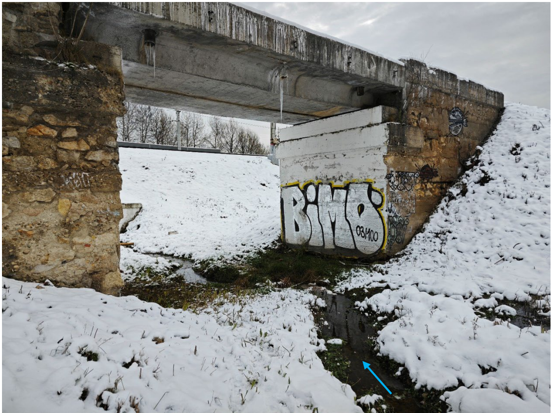
Рисунок 6.12 – Вид на мост через ручей б/н ПК 230+37,8
