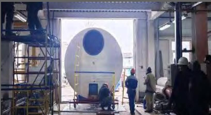
Произведен монтаж 3-х новых котлов в котельной в Катюшках
